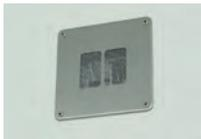
Jede Tiefkühlzelle ist mit einem Druckausgleichsventil ausgestattet.
